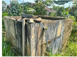
Gambar 1. Tampak depan bak penampung air
