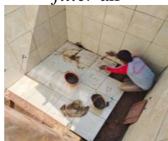
Gambar 9. Pemasangan keramik pada bagian dalam bak
