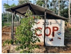
Gambar 18. Tampak kanan bak penampung air
