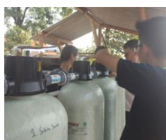
Gambar 11. Pemasangan tabung filter air
