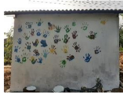
Gambar 19. Tampak belakang bak penampung air
