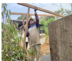
Gambar 10. Pemasangan kayu untuk atap penutup
