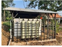
Gambar 16. Tampak depan bak penampung air
