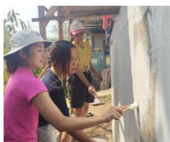
Gambar 12. Pengecatan bagian luar bak
