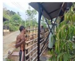
Gambar 15. Pemasangan pagar kayu
