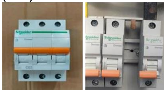
Gambar 2 MCB 3 Phase dan MCB 1 Phase
