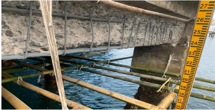
Gambar 2. Gambar Perancah Kerja dilapangan
