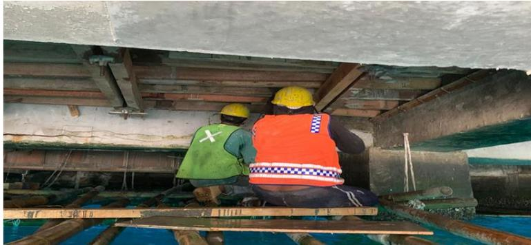
Gambar 16 Pembongkaran Cetakan
