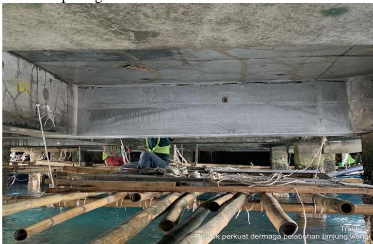
Gambar 18 Hasil Grouting Pada Balok Dermaga.
