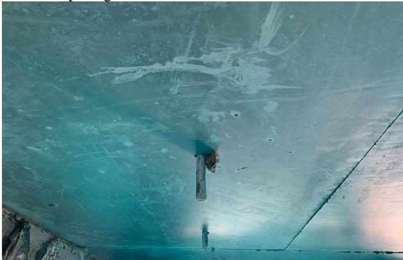
Gambar 17 Hasil Grouting Pada Pelat Dermaga
