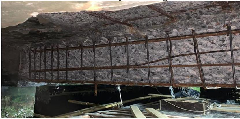
Gambar 6. Pekerjaan Penulangan Balok
