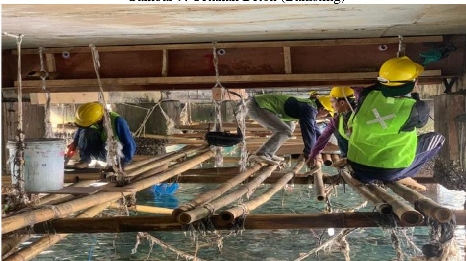
Gambar 10. Cetakan Beton (Bakisting)
