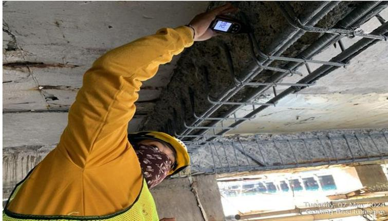
Gambar 8. Pekerjaan Coating Anti Korosi Pada Tulangan Beton dilapangan
